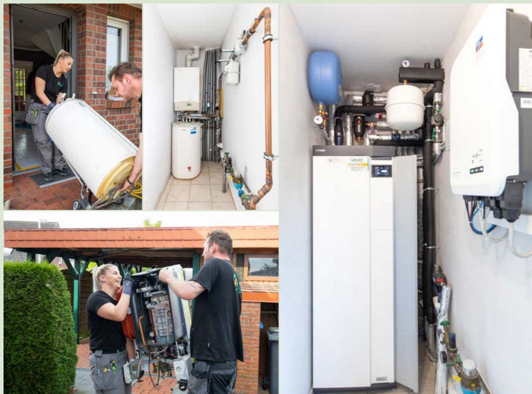
Die alte Gasheizung wurde durch eine smarte NIBE Wärmepumpe ausgetauscht.
